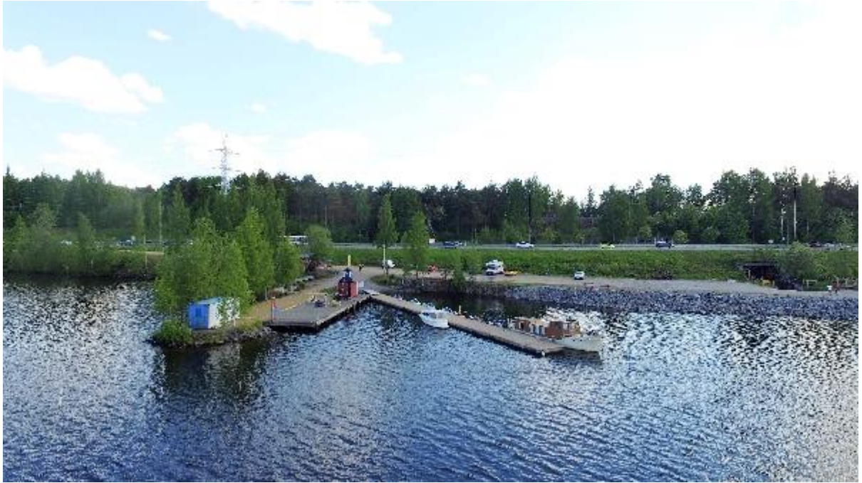
Kuva 30, Uittotunneli I, Tampere
