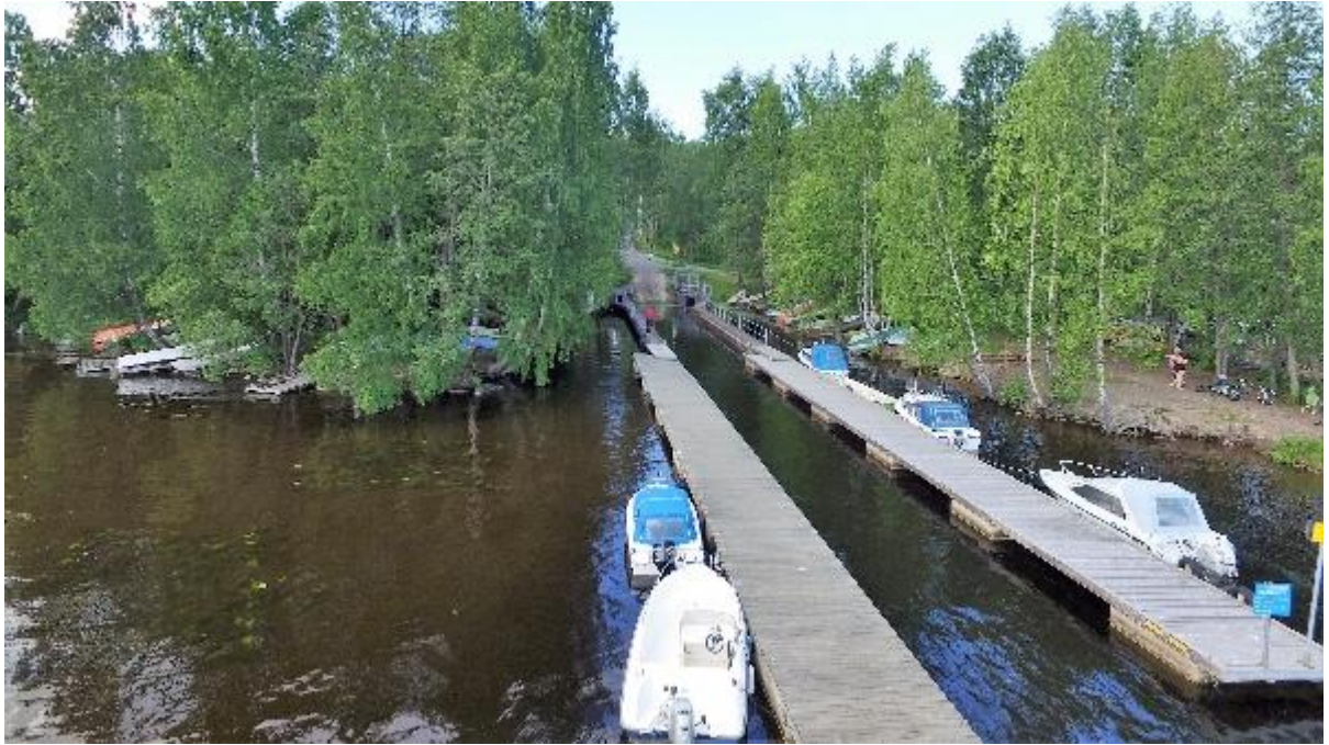
Kuva 39, Uittotunneli II (Hyhky), Tampere
