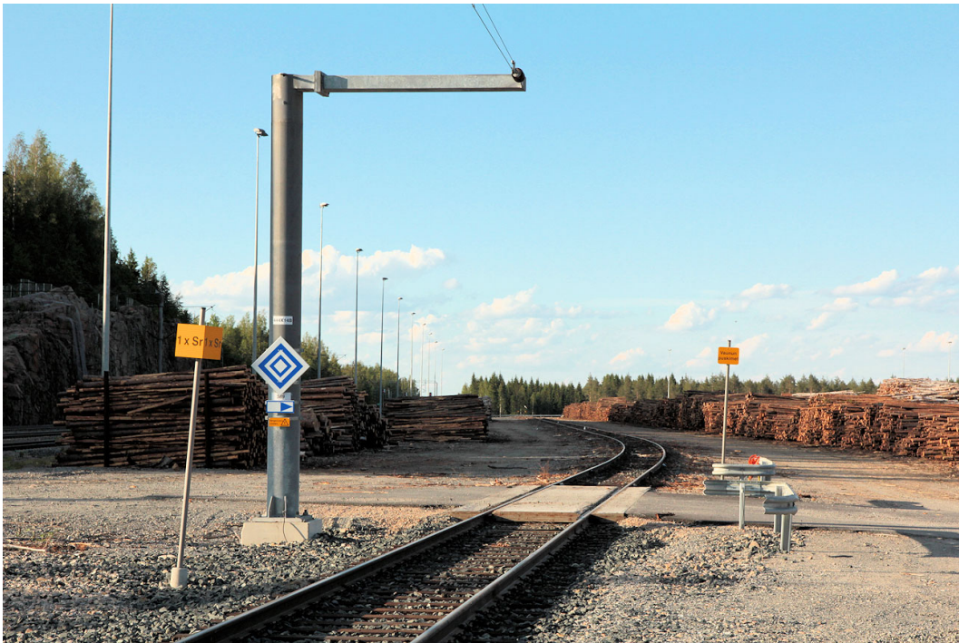
Kuva 6. Ajolanka Kurkimäen kuormausraiteen eteläpäässä. Raakapuuvaunut saadaan sähköveturillakin työnnettyä etualalla olevan tasoisteyksen taakse.
