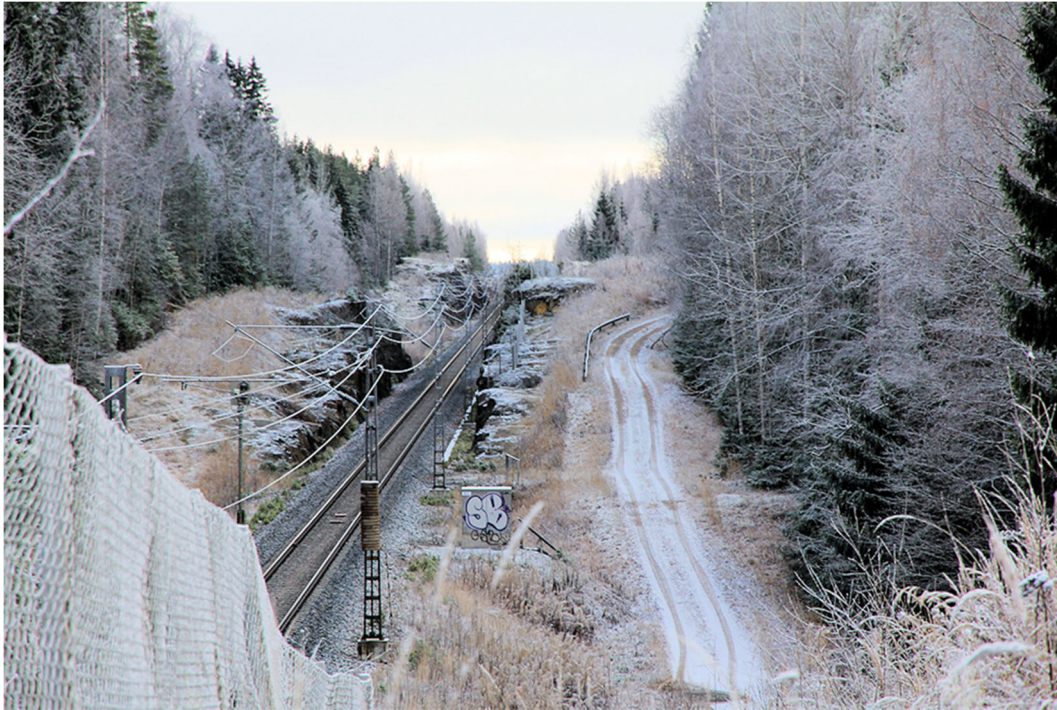
Kuva 11. Uuden-Kuruntien eteläpuolisia kallioleikkauksia. Kuvaussuunta etelään, km 204+900.
