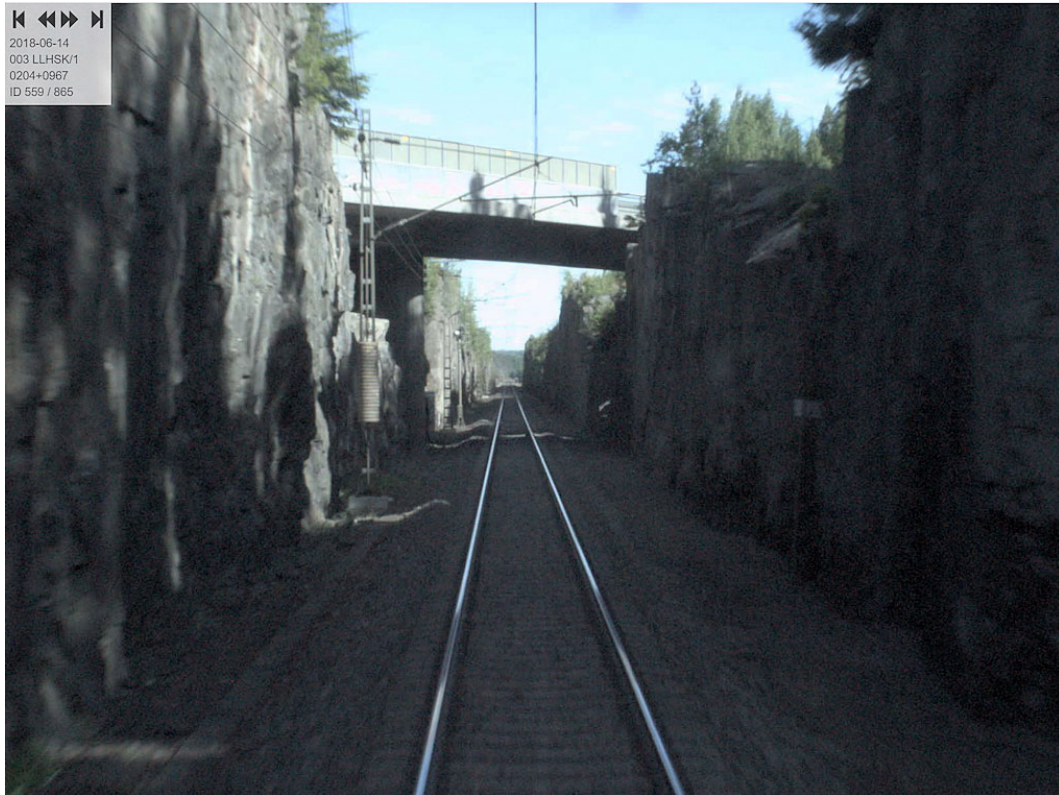
Kuva 16. Kallioleikkaukset km 204+967 pohjoiseen (Ratakuvapalvelu 2018)
