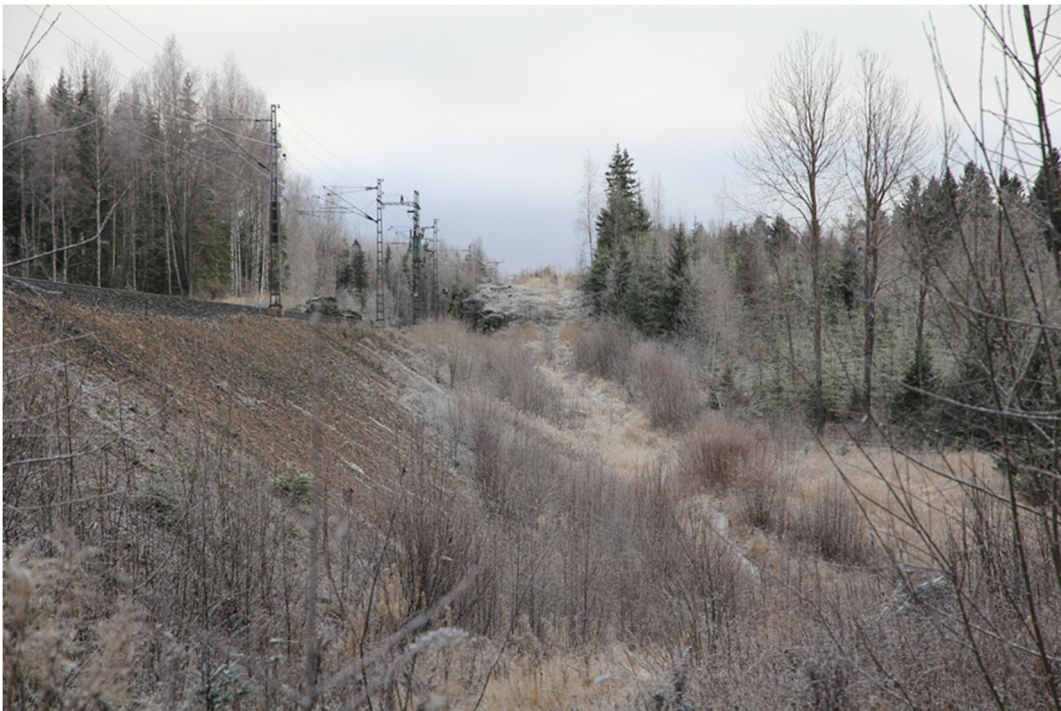
Kuva 15. Kohde 2, kallioleikkausten jälkeinen korkea ratapenger (km 206+300, etelään).
