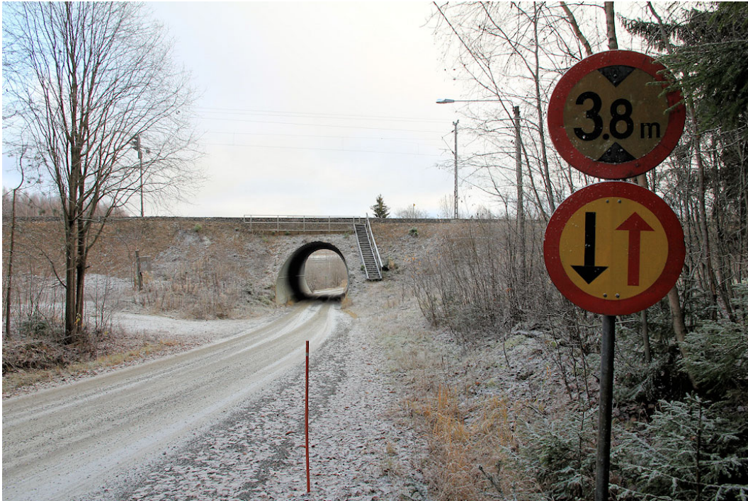
Kuva 17. Kalsintien AK (km 206+387) ja sen takana oleva Uuden-Kuruntien silta eivät mahdollista raskaiden ajoneuvojen läpiajtoa (kuvaussuunta itään).
