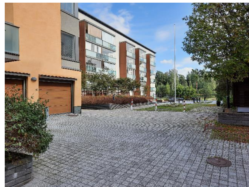
Pihakansi pysäköintilaitoksen päällä säästää tilaa tontilla. Pintavesien ohjauksessa tulee olla huolellinen, ettei kansi ala vuotaa laitokseen. Helsinki, Vuosaari 2021, kuva: WSP
